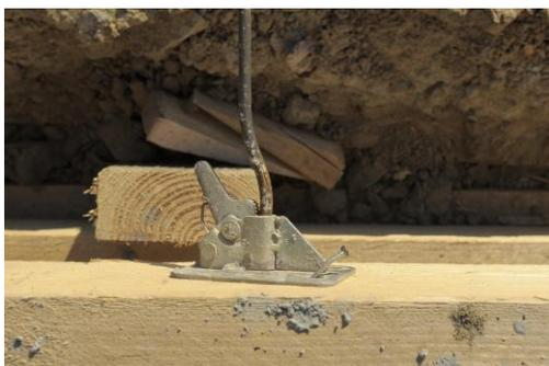
La clavette à ressort, constituée d'un axe excentré et d'un ressort interne, permet de serrer les panneaux de coffrage sur des barres de diamètres 5 à 10mm.
