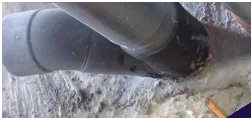
Perçage du fond et passage des gaines.
