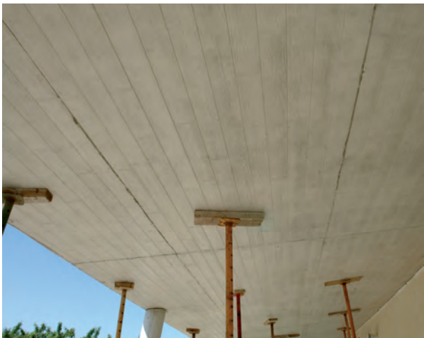
Acabado en hormigón. / EN.Concrete finish. / FR.Finition béton. / DE.Betonbau.
