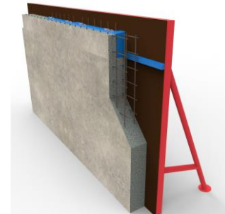
Boucher les espaces entre coffres. Couler le becquet derrière le Modula L NG
