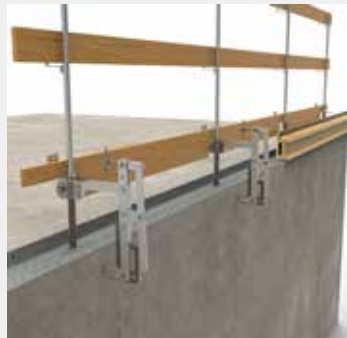
La rive est posée sur le bord du mur et glissée. La pose se fait idéalement à partir de la plateforme de travail
