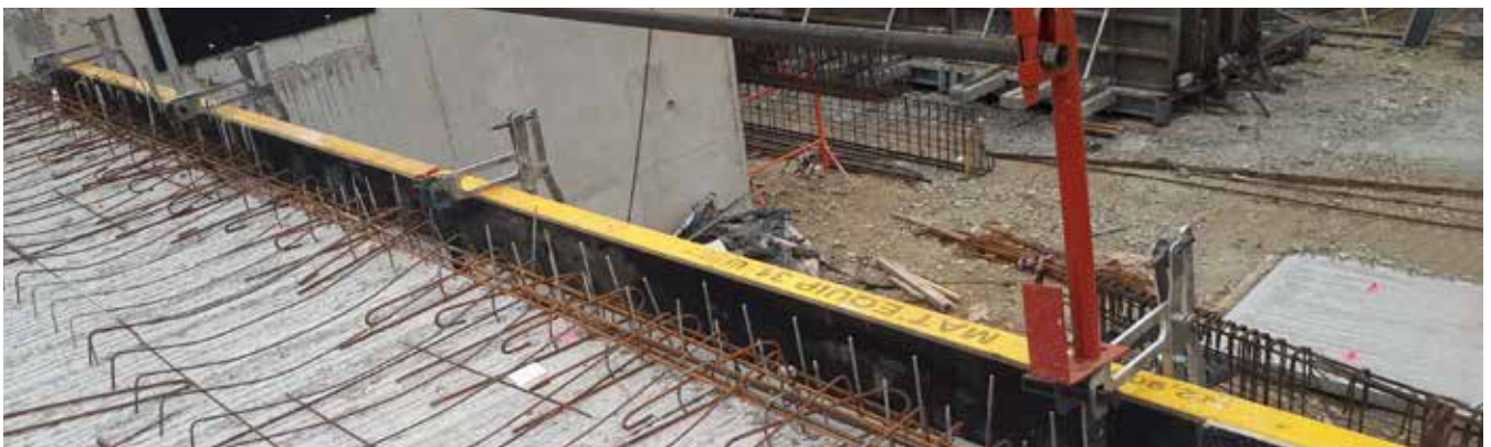
Bétonnage du plancher en sécurité. Possibilité de rajouter un joint mousse en bas de la rive pour éviter les fuites de laitance
