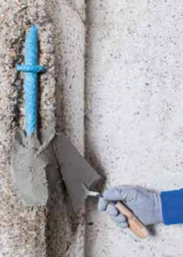
Met een troffel aanbrengen van Planitop Rasa & Ripara R4
