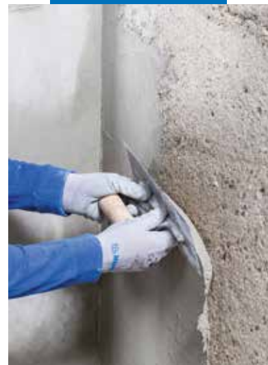
Met een spaan aanbrengen van Planitop Rasa & Ripara R4
