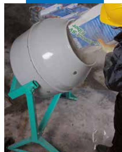
Préparation de la gâchée avec Mapegrout SV Fiber
