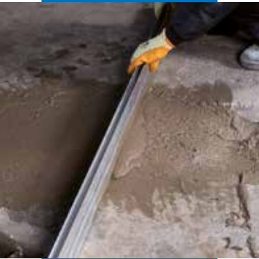
Réglage de Mapegrout SV Fiber
