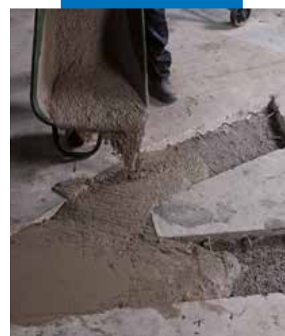
Application de Mapegrout SV Fiber sur la zone à réparer
